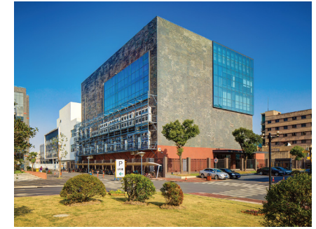
Equinix SH5 Exterior
